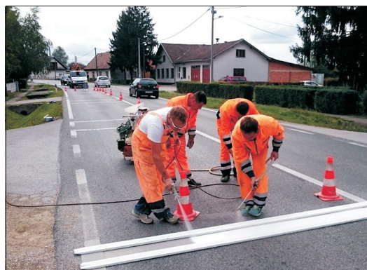
Fig. 1. Application of transverse lines Rys. 1. Wykonywanie linii poprzecznych
