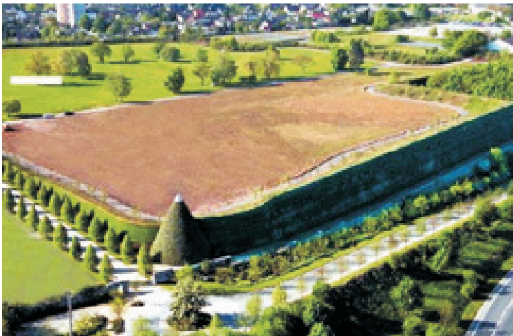
Rys. 1. Ściany oporowe z gruntu zbrojonego geosyntetykami (Niemcy 2001 r., Huesker Synthetic GmbH)
