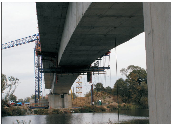
Rys. 1. Widok mostu w Kędzierzynie-Koźlu w trakcie zwania przęseł Fig. 1. View of the bridge span in Kędzierzyn-Koźle, during connecting of cantilevers
