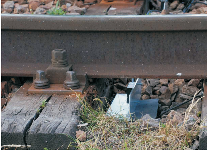
Rys. 2. Fragment toru pomiarowego (widoczny pomiarowy przetwornik laserowy)
