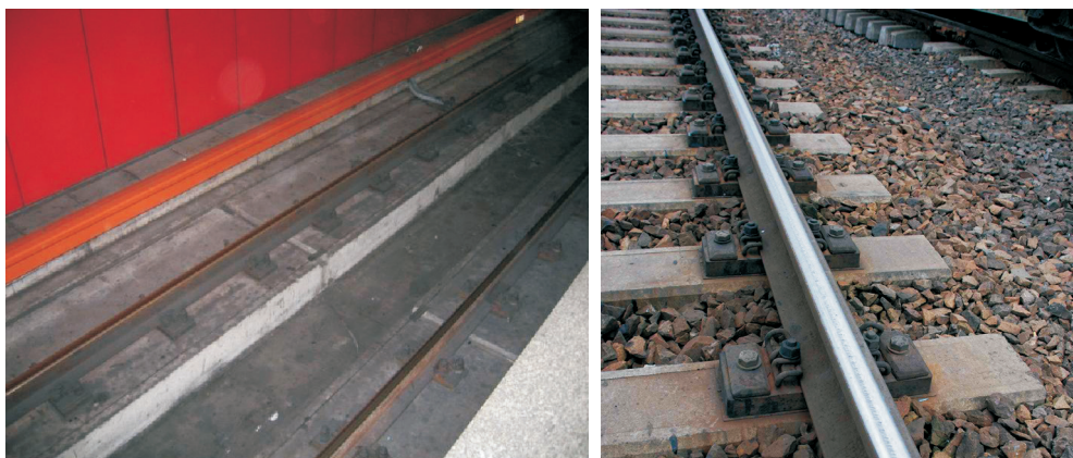
Rys. 2. Fragment torowiska w tunelu metra i na linii klasycznej Fig. 2. Segments of a track in the tunnel of underground railway and on the classic line
