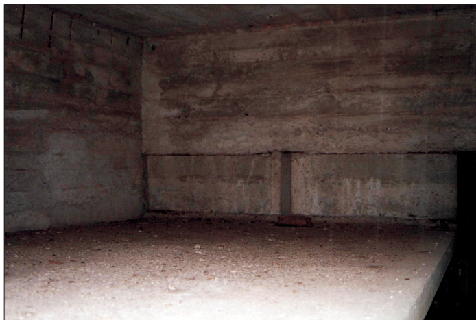
Rys. 6. Przestrzeń między pomostem a płytami ściągu
