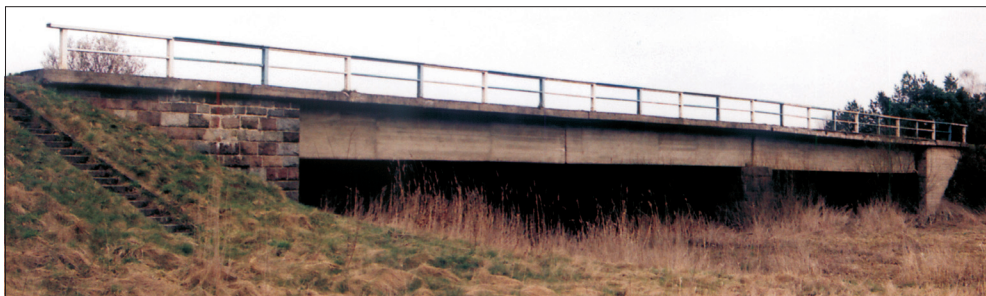
Rys. 1. Most przez rzekę Inę Fig. 1. The bridge over the Ina river
