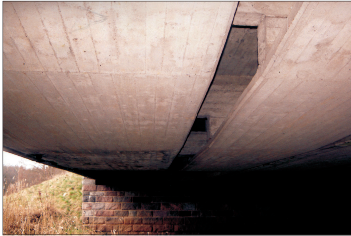
Rys. 5. Widok przęsła od spodu
