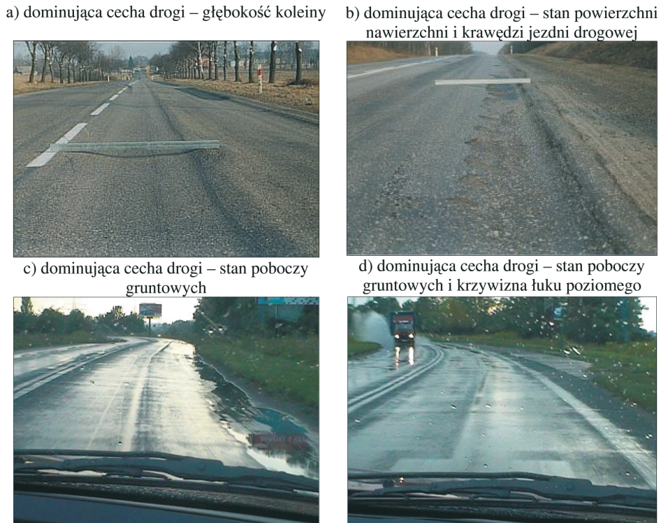
Rys. 11. Różny stan nawierzchni i poboczy gruntowych
