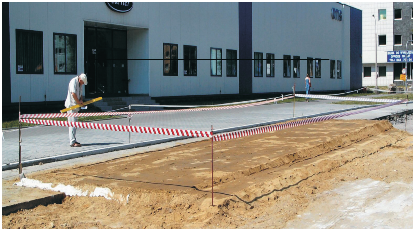
Rys.11. Widok z prawego narożnika poligonowego poletka Fig.11. View of the small testing field – right corner
