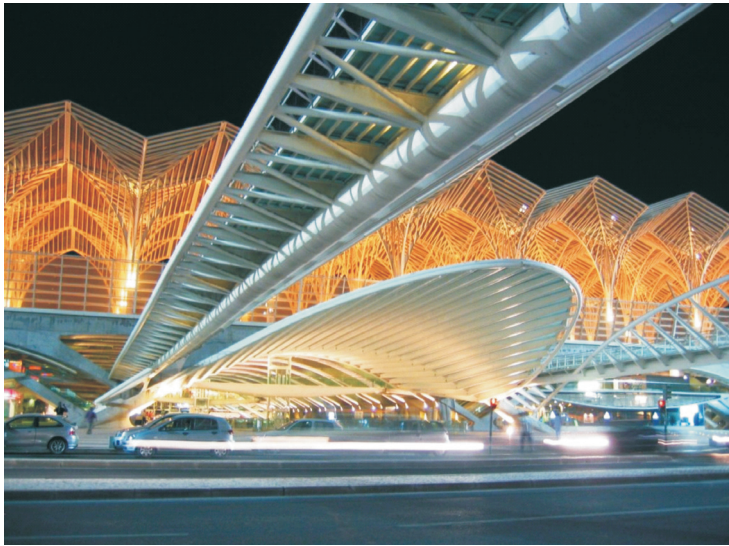
Rys.2. Elementy betonowej konstrukcji dworca kolejowego w Lizbonie (1993-1998), architekt Santiago Calatrava
