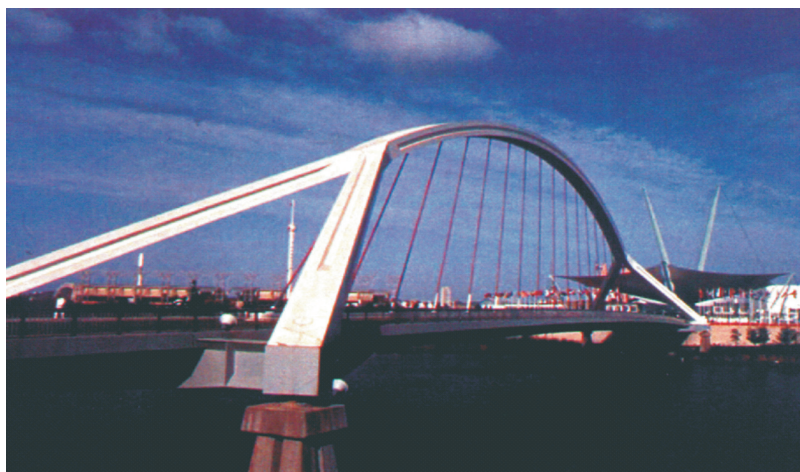
Rys.8. Most Barqueta, Sevilla 1998 [29] http://www.arenasing.com/ingles/menu_1/proyectos/p_urbanos/oblatas/informacion.html Fig.8. Bridge of Barquet, Sevilla 1998 [29]
