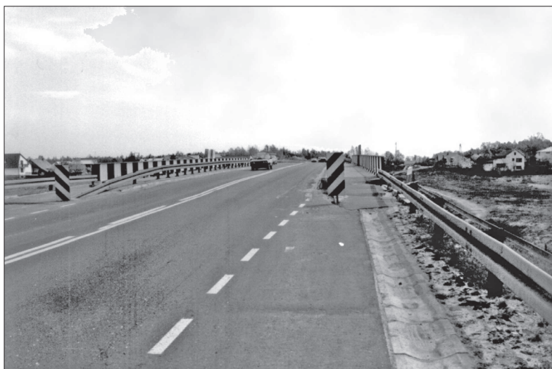
Rys.1. Most, którego przekroju poprzecznego nie dostosowano do przekroju drogowego Fig.1. The bridge not aligned to the approach
