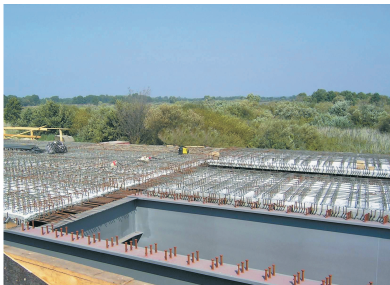
Rys.3. Żelbetowe płyty prefabrykowane ułożone na belkach stalowych mostu zespolonego Fig.3. Precast reinforced concrete panels placed on steel beams of a composite bridge
