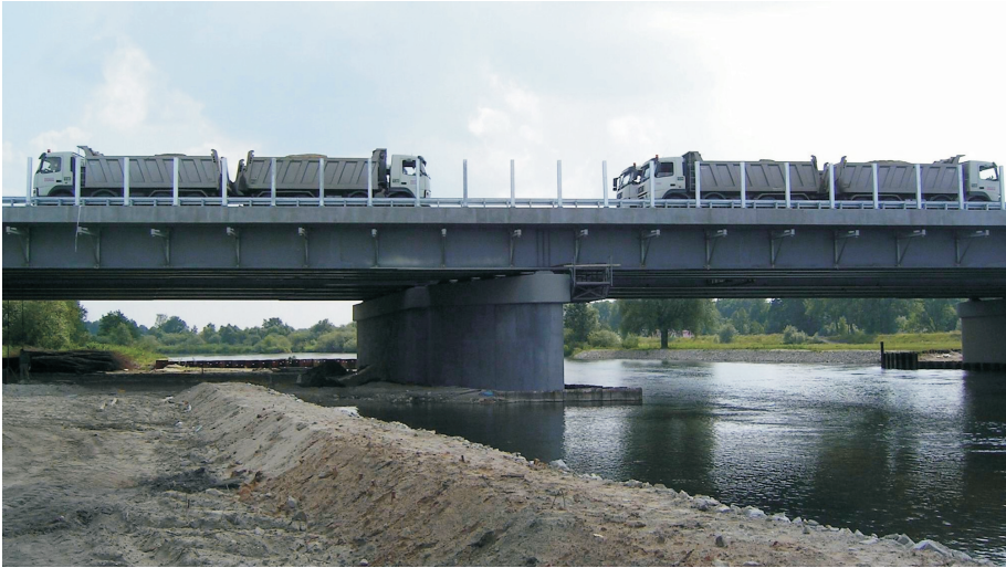
Rys.10. Obciążenie samochodami mostu północnego w trakcie realizacji schematu S-IV Fig.10. Trucks located on the northern bridge during load case S-IV
