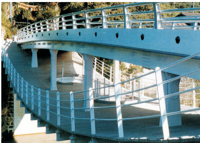
Rys.4. Przeobrażenie idei - „most wstęgowy” Fig.4. Transformed idea – „ribbon bridge” (photo E.M. Kido: Mamihara Bridge 1995)
