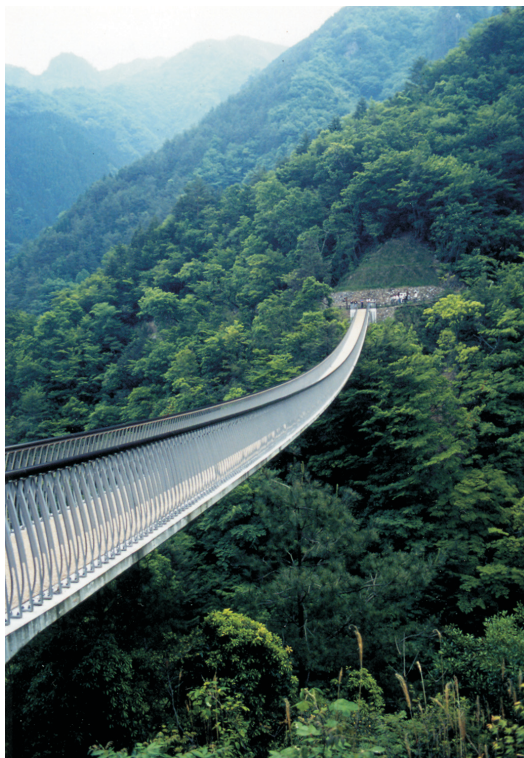
Rys.2. Współczesny most wstęgowy Fig.2. Contemporary ribbon bridge (photo E.M. Kido: Plum Tree Garden Bridge 1989)
