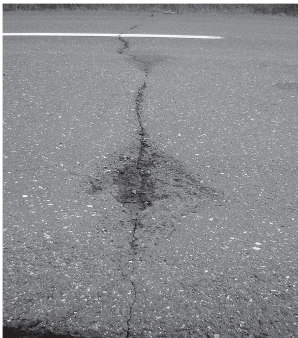
Rys.2. Przykład postępującego zniszczenia konstrukcji nawierzchni po powstaniu spękania niskotemperaturowego Fig.2. An example of proceeding deterioration of asphalt pavement after low temperature cracking has occurred
