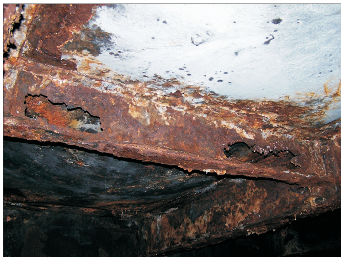
Rys.6. Korozja jednej z poprzecznic pośrednich wiaduktu na węźle Brama Oliwka w Gdańsku
