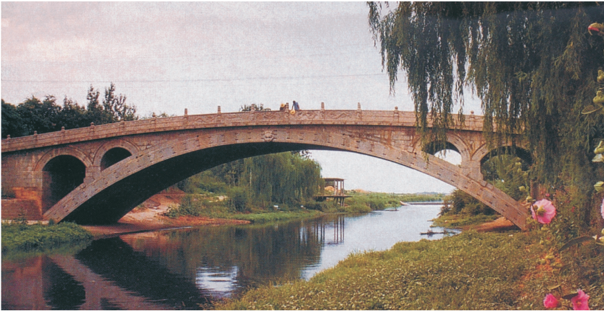
Rys.1. Wielki Kamienny Most nad rzeką Jiao zbudowany przez Li Chuna w 610 r. [2] Fig.1. Great Stone Bridge above river Jiao built by Li Chun in 610 [2]
