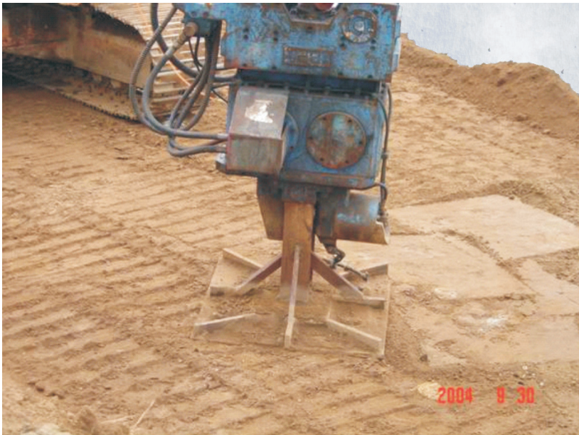
Rys.3. Sposób zagęszczania gruntu
