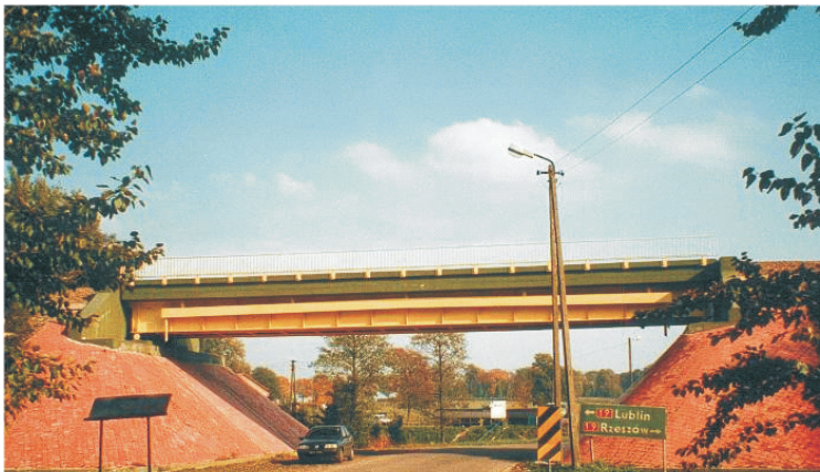
Rys.28. Krzykliwa dominacja wybrukowanych nasypów (fot. G. Łagoda) Fig.28. Noisy domination of paved embankments (photo G. Łagoda)
