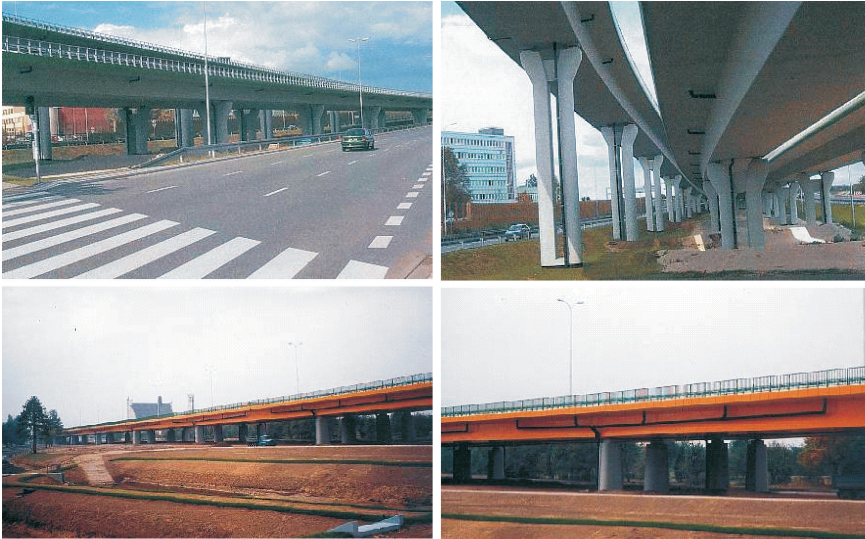
Rys.40. Przykłady odmiennego podejścia z punktu widzenia estetyki do rozwiązania szczegółów odwodnienia wiaduktów (fot. M. Łagoda)
