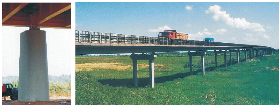
Rys.26. Wyraźne eksponowanie łożysk (fot. M. Łagoda i Mostostal Kraków) Fig.26. Clear exhibiting of bearings (photos M. Łagoda and Mostostal Kraków)
