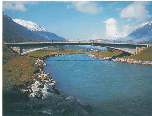
Rys.8. Rustykalna wykładzina przyczółka [8] Fig. 8. Rustical facing of bridge abutment [8]
