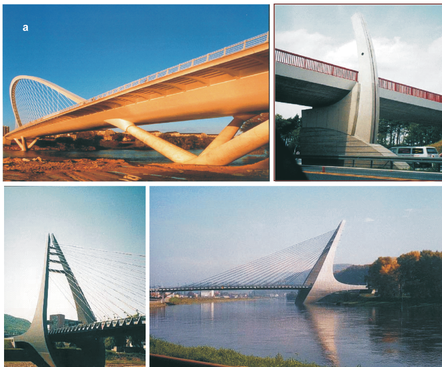
Rys.11. Nietypowe obiekty mostowe (a [14], pozostałe fot. G. Łagoda) Fig.11. Atypical bridge structures(a [14], other photos G. Łagoda)
