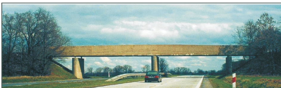
Rys. 24. Wrażenie ciężkości i pustki tam, gdzie nie ma rozdziału między balustradą a ustrojem nośnym (fot. M. Łagoda)
