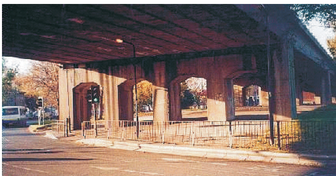
Rys.19. Podpory ścienne z otworami (fot. M. Łagoda) Fig.19. Wall supports with openings (photo M. Łagoda)
