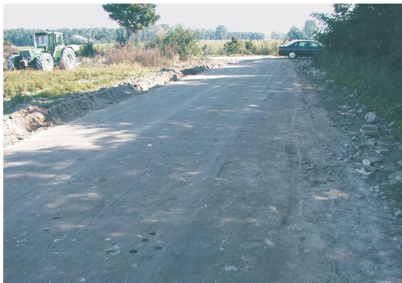
Rys.9. Widok odcinka po wykonaniu, przed przykryciem pospółką (październik 2002 r.)
