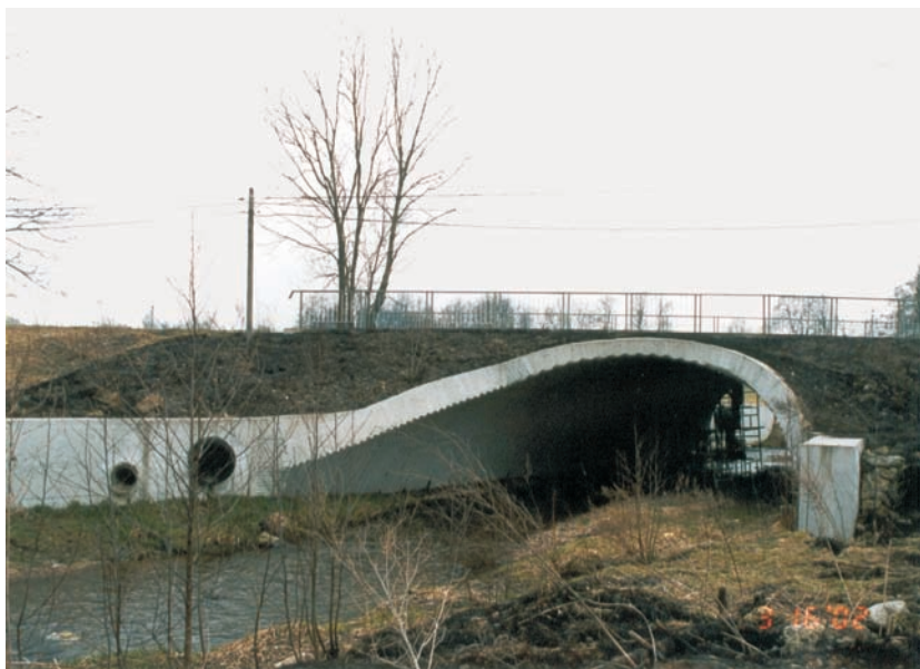
Rys.3. Widok z boku na konstrukcję mostu wykonanego z blach falistych typu Multiplate V45 od strony dolnej wody
