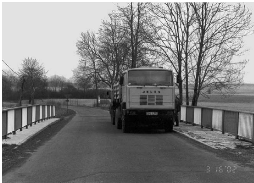
Rys.4. Widok od czoła na most od strony miejscowości Bystrzyca Kłodzka podczas wykonywania badań (I schemat obciążenia) Fig.4. Front view of the bridge from the side of Bystrzyca Kłodzka during testing (load scheme I)
