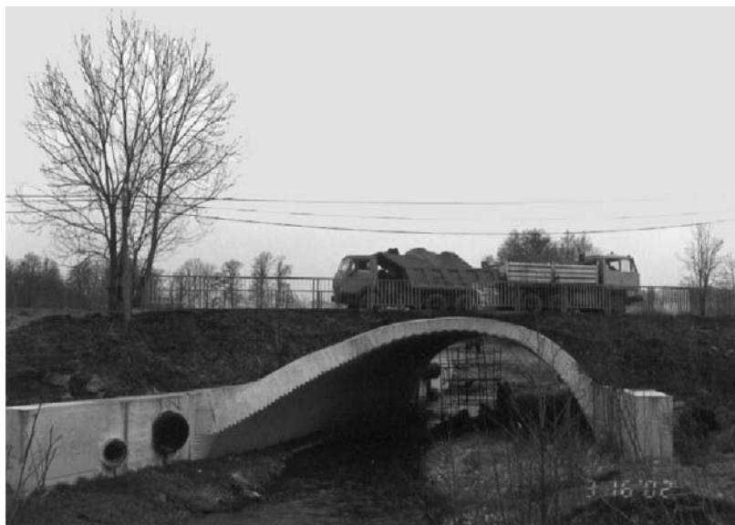
Rys.5. Widok z boku od strony dolnej wody na most podczas wykonywania badań (II schemat obciążenia)
