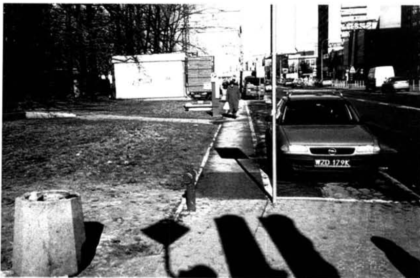
Rys.3. Zbyt mała przestrzeń pozostawiona pieszym dodatkowo ograniczona złym ustawieniem hydrantu. Warszawa ul. Żelazna
