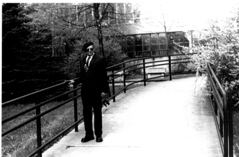
Rys.9. Pochylnia zewnętrzna o szerokości ok. 2,8 m, balustrada z rur z poręczą. Pochylnia nie nadaje się do samodzielnego wjeżdżania i zjeżdżania wózkami inwalidzkimi. Poręcz w balustradzie jest za wysoka nawet dla pieszych (1,1 m). Kielce, Politechnika Fig.9. External ramp, 2,8 m wide, balustrade made of pipes with a railing. The ramp is rather not very useful for driving in or driving out for men on wheelchairs. Railing on the balustrade is too high for pedestrians too (1,1 m). Kielce, University of Technology
