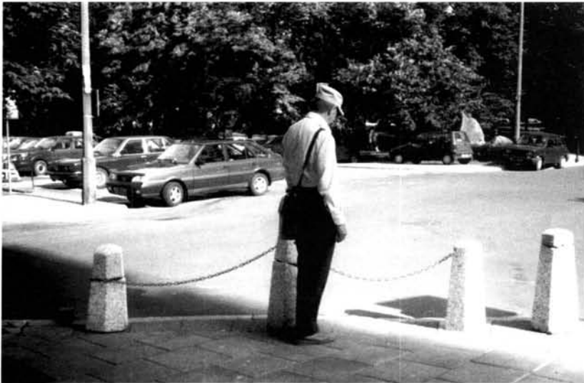
Rys.4. Słupki za niskie i łańcuchy tylko na jednym poziomie i zbyt nisko zwisające, stanowią zagrożenie bezpieczeństwa pieszych. Warszawa, ul. Prusa Fig.4. Such posts are too low, chains are only at one level, they are dangerous for pedestrians. Warsaw, Prusa Str.
