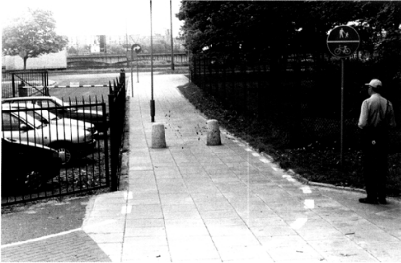
Rys.7. Wspólna droga dla pieszych i rowerzystów jest przegrodzona słupkami - babami, niewyróżnionymi barwami kontrastowymi. Kto komu ma ustępować pierwszeństwo?! Fig.7. Common route for pedestrians and cyclists is split into two parts by posts, which are not visible enough. Who should give way?!
