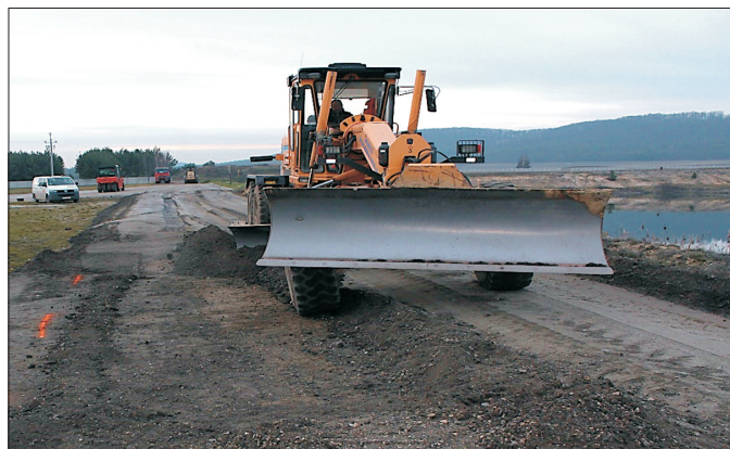
Fig. 12. Grading of the recycled base course [68, 69] Rys. 12. Profilowanie recyklowanej warstwy [68, 69]
