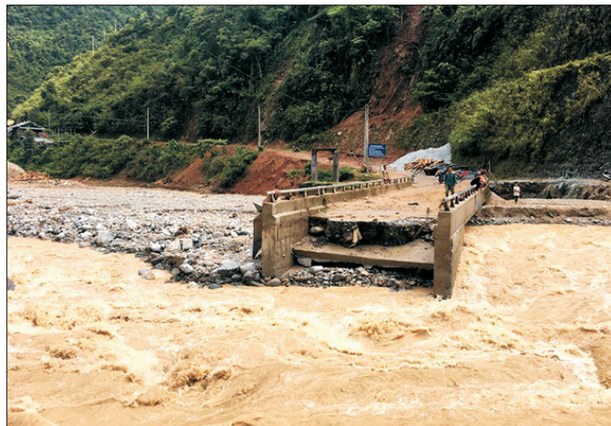
Fig. 1. Bridge destroyed by a debris flow, Vietnam (2019) Rys. 1. Most zniszczony przez sływ rumoszowy, Wietnam (2019)
