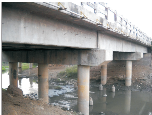
Fig. 6. Kamra Bridge with contiguous spans Rys. 6. Most Kamra Bridge o konstrukcji złożonej z przylegających do siebie przęseł
