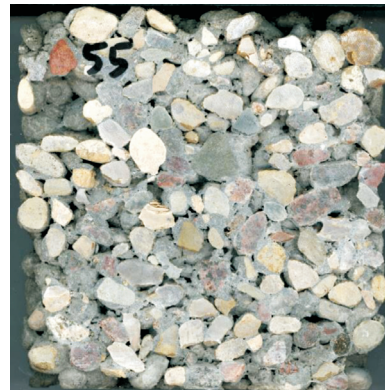
Fig. 11. Section through concrete design no. 55 Rys. 11. Przekrój próbki o składzie nr 55
