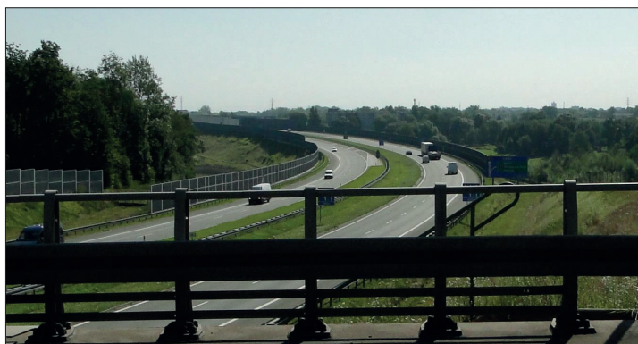
Fig. 5. View of the A1 Highway from the bridge carrying the Celna Street in Bytom towards the east into the area of the deepest closed basin lake in the “Bytom – Centrum I” MSA Rys. 5. Widok autostrady A1 z wiaduktu dla ul. Celnej w Bytomiu w kierunku wschodnim na rejon dna najgłębszej niecki bezodpływowej w terenie górniczym „Bytom – Centrum I”
