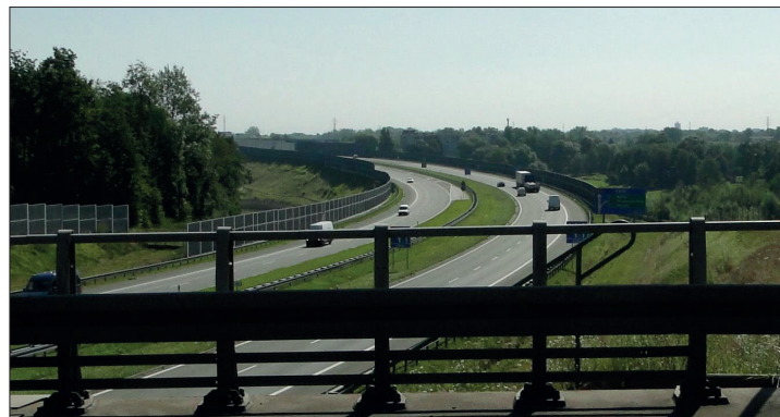
Fig. 5. View of the A1 Highway from the bridge carrying the Celna Street in Bytom towards the east into the area of the deepest closed basin lake in the “Bytom – Centrum I” MSA Rys. 5. Widok autostrady A1 z wiaduktu dla ul. Celnej w Bytomiu w kierunku wschodnim na rejon dna najgłębszej niecki bezodpływowej w terenie górniczym „Bytom – Centrum I”
