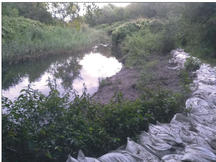
Fig. 3. View of the Szarlejka river in the surroundings of Podmiejska St. in Piekary Śląskie in the vicinity of the A1 Highway and the point of the river's outflow from the “Bytom – Centrum I” MSA Rys. 3. Widok rzeki Szarlejka w okolicy ul. Podmiejskiej w Piekarach Śląskich w rejonie autostrady A1 i miejsca odpływu wód rzeki z terenu górniczego „Bytom – Centrum I”
