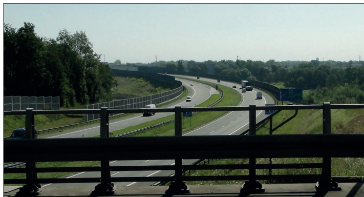
Fig. 5. View of the A1 Highway from the bridge carrying the Celna Street in Bytom towards the east into the area of the deepest closed basin lake in the “Bytom – Centrum I” MSA Rys. 5. Widok autostrady A1 z wiaduktu dla ul. Celnej w Bytomiu w kierunku wschodnim na rejon dna najgłębszej niecki bezodpływowej w terenie górniczym „Bytom – Centrum I”
