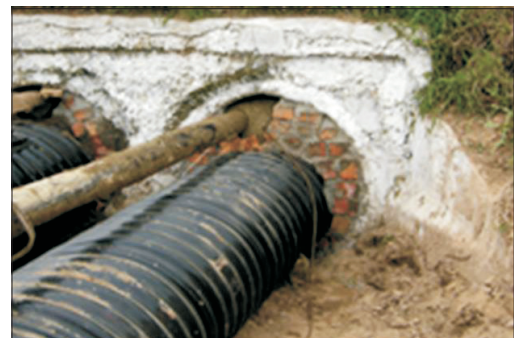
Fig. 2. Reconstruction of bridge crossings and defective reinforced concrete pipes using corrugated metal structures Rys. 2. Naprawa obiektów mostowych i przepustów z zastosowaniem elementów z blachy falistej
