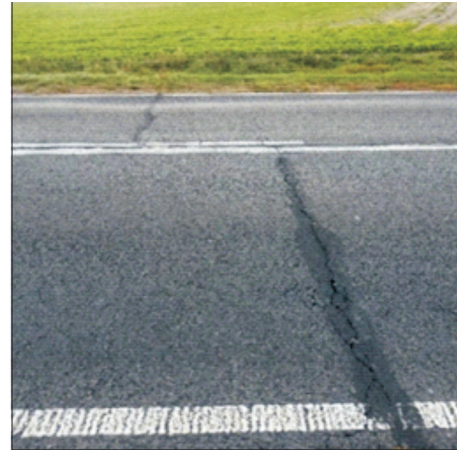
Fig. 8. Transverse cracks on the road section DK 19 observed in 2016 (photo by J. Kukielka) Rys. 8. Pęknięcia poprzeczne na odcinku drogi DK 19 zaobserwowane w 2016 r. (zdjęcia: J. Kukielka)
