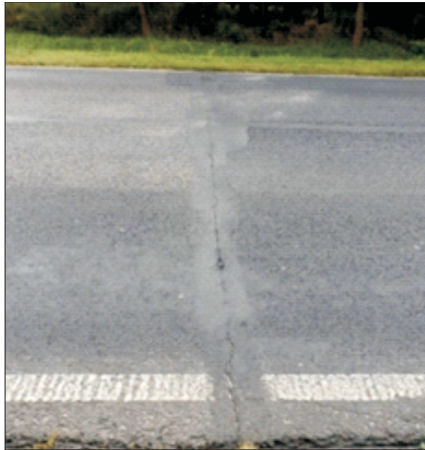
Fig. 8. Transverse cracks on the road section DK 19 observed in 2016 (photo by J. Kukielka) Rys. 8. Pęknięcia poprzeczne na odcinku drogi DK 19 zaobserwowane w 2016 r. (zdjęcia: J. Kukielka)
