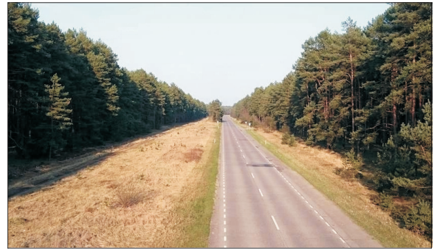
Fig. 3. View of DW 142 regional road Rys. 3. Widok drogi wojewódzkiej DW 142
