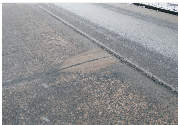
Fig. 6. Preparation for renovation of the old pavement (a) and the anti-crack layer (b) on DW 102 regional road Rys. 6. Przygotowanie do remontu starej nawierzchni (a) oraz warstwa antyspekaniowa (b) na drodze wojewódzkiej DW 102
