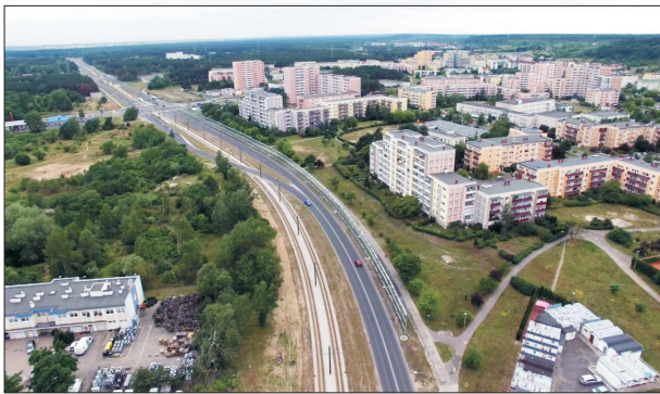
Fig. 2. View of the investment location (photo by K. Pietrzak) Rys. 2. Widok lokalizacji inwestycji (fot. K. Pietrzak)
