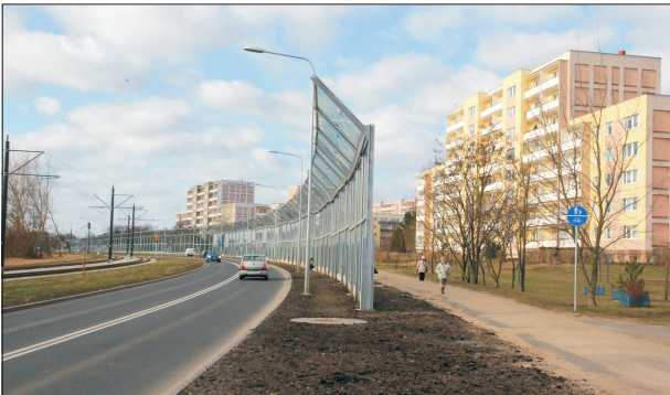
Fig. 3. Noise barriers along the tramway after completion of the investment (photo by K. Pietrzak) Rys. 3. Ekrany akustyczne wzdłuż linii tramwajowej po zakończonej inwestycji (fot. K. Pietrzak)
