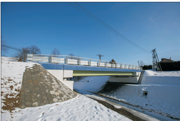
Fig. 6. Bridge in Błażowa with the LWC/GFRP deck slab Rys. 6. Most w Błażowej z płytą pomostu typu LWC/GFRP
