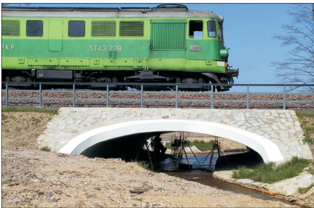
Fig. 1. View of structure during testing Rys. 1. Widok obiektu podczas badania
