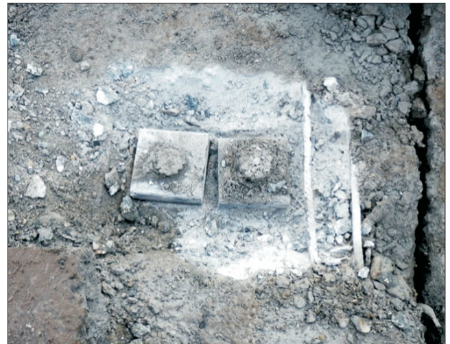
Fig. 5. View at the original upper anchorages of cables Rys. 5. Widok oryginalnie zamontowanych górnych zakotwień
