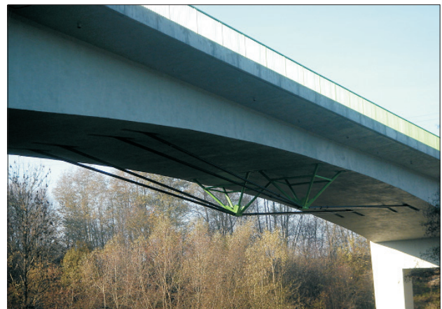
Rys. 15. Szczegół usztywnienia za pomocą zewnętrznej konstrukcji sprężającej zabudowanej na głównym przęsle
