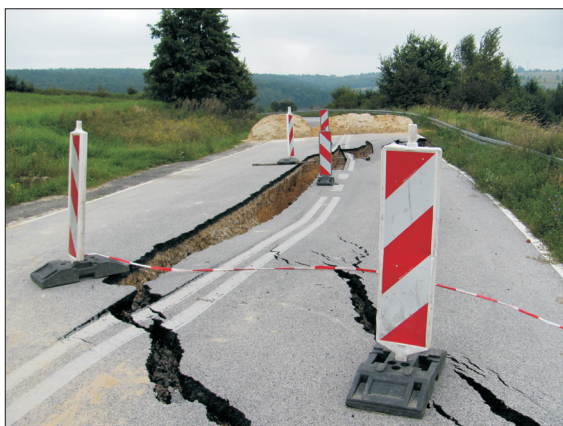
Fig. 1. View of the damaged road – September 2014 Rys. 1. Widok na uszkodzenia drogi – wrzesień 2014 photo / fot. J. Rubinkiewicz
