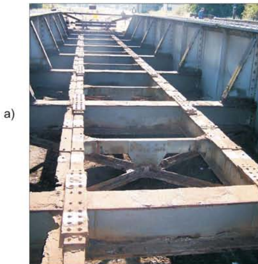
Fig. 2. Corroded beam floor: a) general view, b) corroded top flange of a stringer Rys. 2. Skorodowany pomost belkowy: a) widok ogólny, b) skorodowany pas górny podłużnicy
