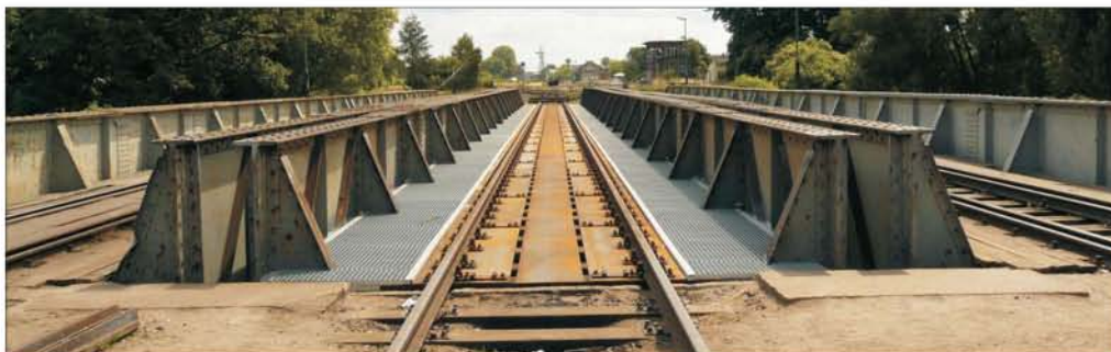
Fig. 4. General view of the bridge after beam floor repair Rys. 4. Widok ogólny mostu po naprawie pomostu belkowego
