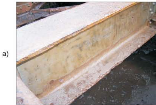
Rys. 3. Corroded elements after sandblasting: a) a cross beam, b) a gusset plate in a stringer connection Rys. 3. Skorodowane elementy po oczyszczeniu: a) poprzecznic, b) blacha węzłowa w połączeniu podłużnic
