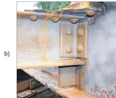
Rys. 3. Corroded elements after sandblasting: a) a cross beam, b) a gusset plate in a stringer connection Rys. 3. Skorodowane elementy po oczyszczeniu: a) poprzecznic, b) blacha węzłowa w połączeniu podłużnic
