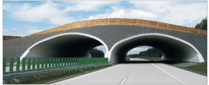
Fig. 1. Wildlife crossing over A4 motorway Rys. 1. Przejście dla zwierząt nad autostradą A4
