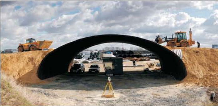
Fig. 2. The structure during construction Rys. 2. Badany obiekt w trakcie budowy
