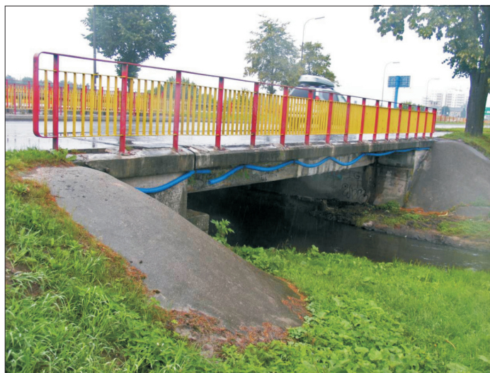
Fig. 2. Bridge side view Rys. 2. Widok mostu z boku
