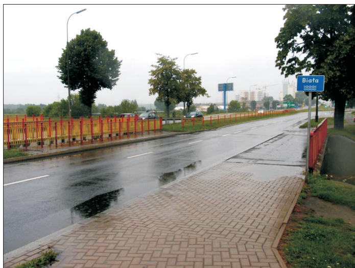
Fig. 1. General view of the bridge Rys. 1. Ogólny widok mostu z góry
