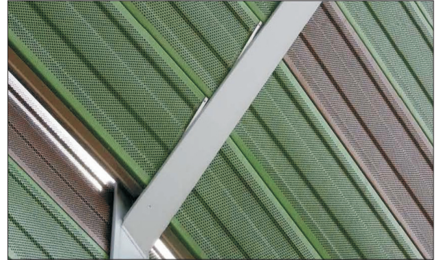
Fig. 4. Not sufficiently supported panels in the barrier inclined part Rys. 4. Zbyt małe oparcie paneli na części pochyłej ekranu
