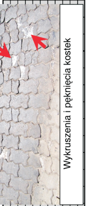
Maksymalna szerokość wykruszenia krawędzi pęknięć
