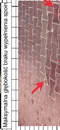
Maksymalna głębokość braku wypełnienia spoin i fakt spłynięcia zaprawy asfaltowej
