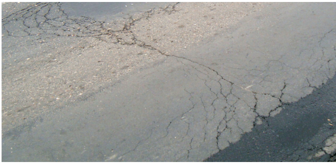
Rys. 5. Typowy wielowartościowy obraz spękanej nawierzchni z MMA
