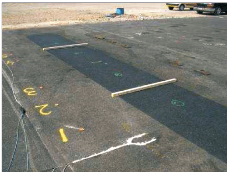
Rys. 11. Widok nawierzchni po badaniu HVS Fig. 11. The view of the pavement after HVS test
