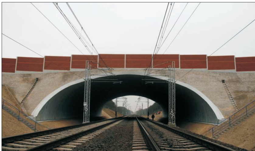
Rys. 3. Przejście dla zwierząt o konstrukcji gruntowo-powłokowej w Gajcu Fig. 3. Animal overpass soil-steel structure in Gajec
