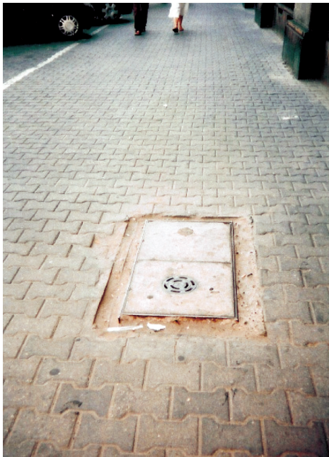
Fot. 1. Zniszczona pokrywa i fragment zwieńczenia – widoczne znaczne ubytki betonu, odkryte zbrojenie, pęknięta oprawa żeliwna pokrywy
