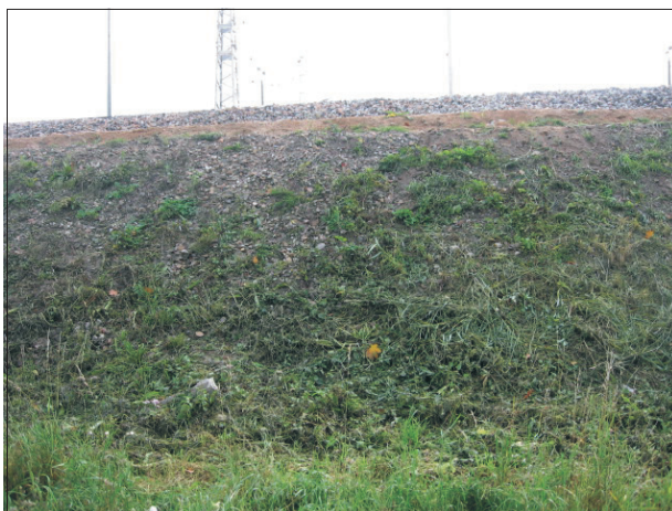
Rys. 1 Intensywnie rozwinięta roślinność u podnóża skarpy (ubogie zazielenienie na skarpie)
