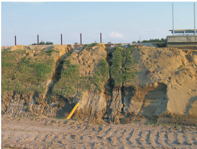
Rys. 3. Żleby erozyjne na skarpie powstałe wskutek żłobinowych zmywów Fig. 3. Erosive gutters created by grooving run-off
