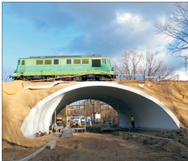
Fig. 2. Position of locomotive during acceptance tests Rys. 2. Położenie lokomotywy na obiekcie podczas badań odbiorczych
