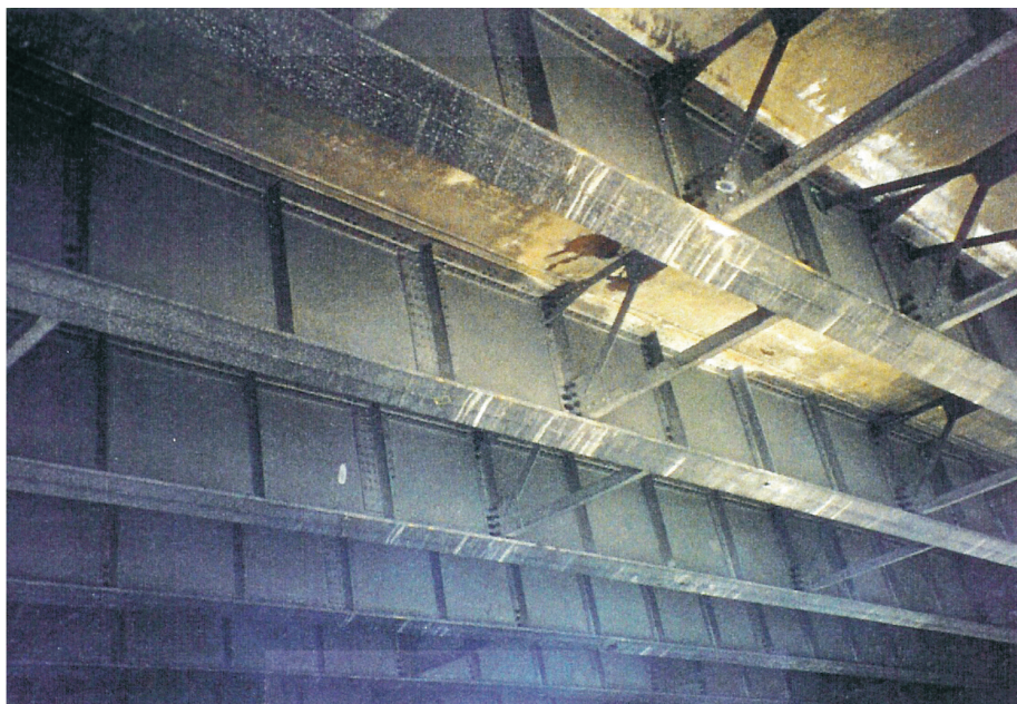
Rys.6. Konstrukcja nitowanego wiaduktu aluminiowego nad Jericho Turnpike w Nowym Jorku, USA
