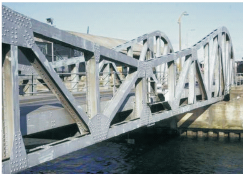
Rys.1. Pierwszy aluminiumowy most zwodzony w Sunderland, Anglia Fig.1. The first aluminium movable bridge in Sunderland, England
