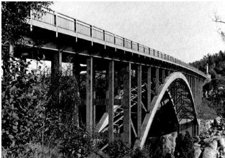
Rys.2. Najdłuższy aluminiowy most drogowy w Arvida, Kanada Fig.2. The longest aluminium road bridge in Arvida, Canada
