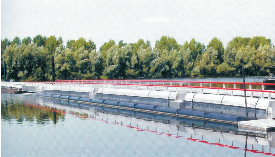
Rys.15. Aluminiowa pływająca droga w Holandii Fig.15. The aluminium floating road in Holland
