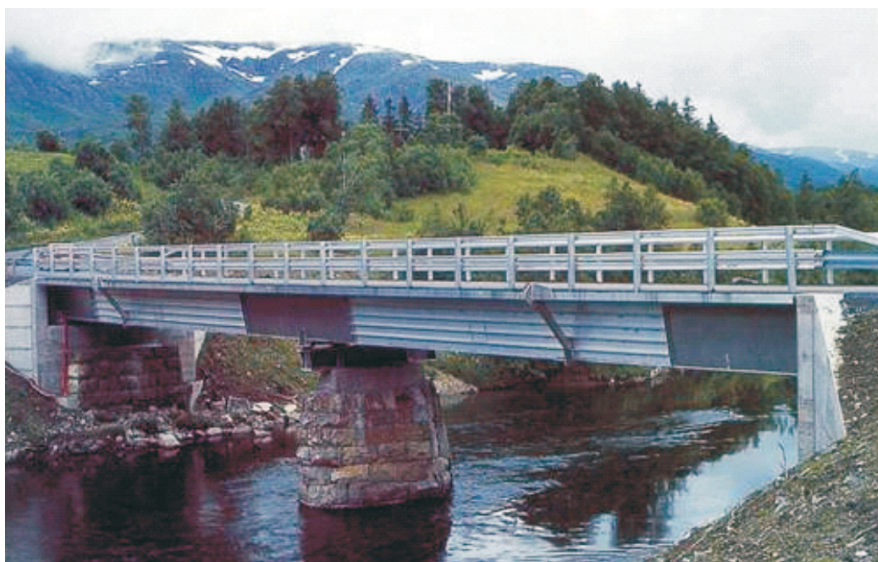
Rys.11. Współczesny most aluminiowy nad rzeką Forsmo w Norwegii Fig.11. The contemporary aluminium bridge in Forsmo, Norway
